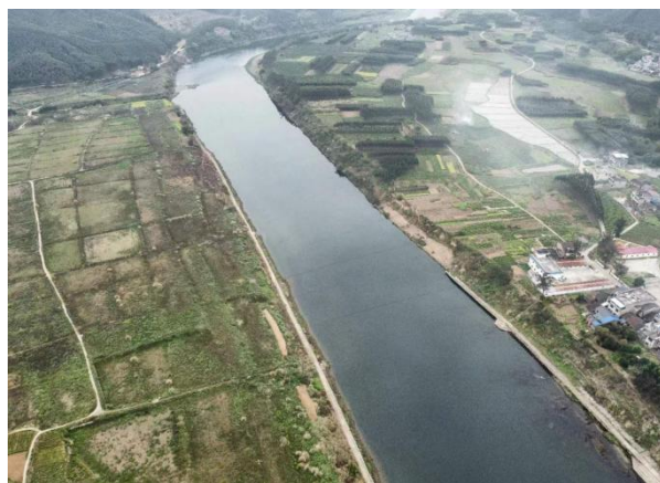
项目西面黄冕河
